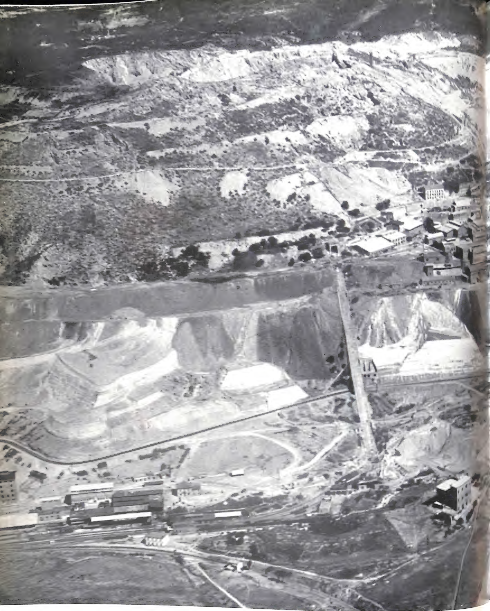
Panorama degli impianti m
